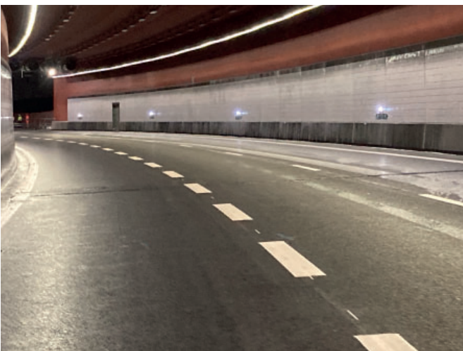
Mariefholmstunnel Göteborg Schweden
